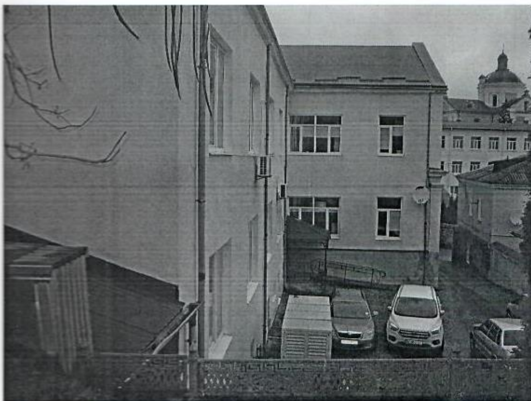
Рисунок Д.2.1 – Загальний вигляд будівля учбового корпусу №1, що знаходиться за адресою: Тернопільська обл., Кременецький р-н, м. Кременець, вул. Словацького, буд. 12
